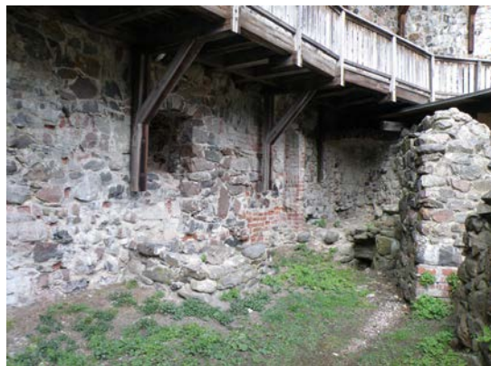
Panimohuone. Vasemmalla ulkoseinää vasten oleva koroke, päädyssä komero tai uuni ja sen alle johtava viemäri. Kuva: Georg Haggrén.
