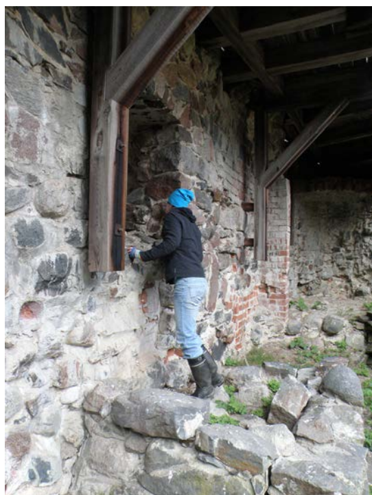
Panimon muuripadan perustukseksi tulkittu rakenne. Kuva: Georg Haggrén.
