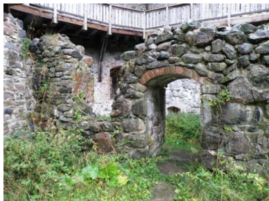
Keittiötilan sisäänkäynti. Kuva: Georg Haggrén.
