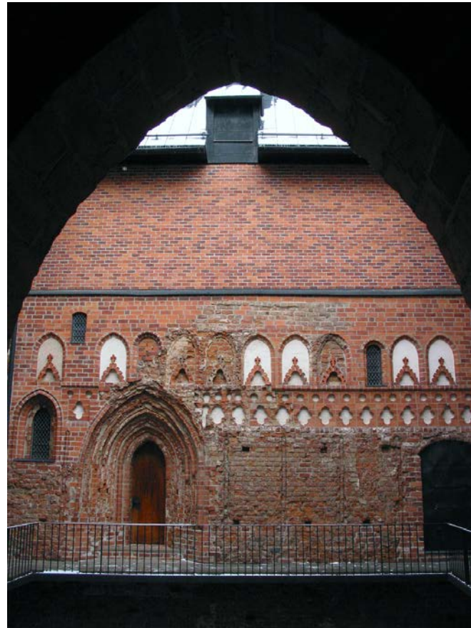
Kuva 5. Näkymä Kukkotornin parvekekäytävälle johtavalta ovelta sisäpihan yli tiilikomeroon koristeltuun koillissiiven seinään. Kuva Terhi Mikkola
