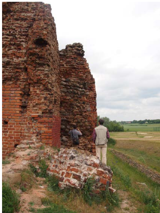
Bobrownikin linnan seiniä tutkitaan ja dokumentoidaan. Kuva Terhi Mikkola.
