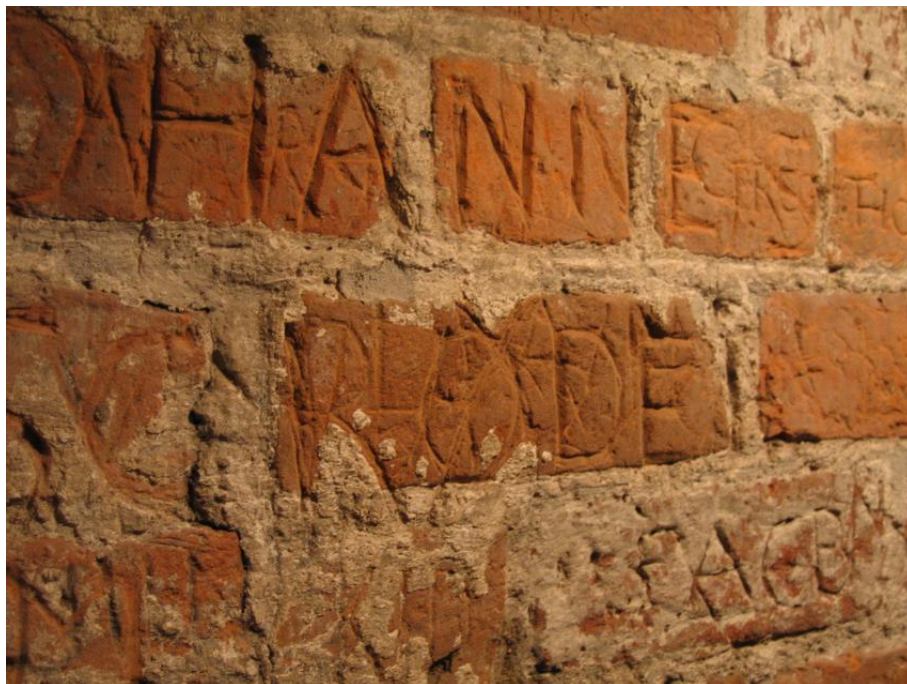
Opiskelijoiden riipustuksia Konsistorie- husetin kellarin seinissä.
