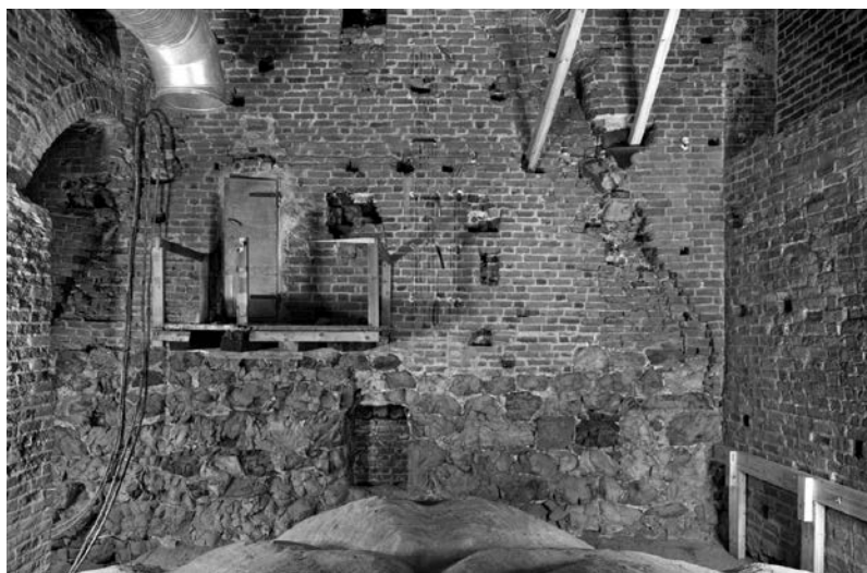
Fig. 2: Sakristivinden mot söder. I fonden långhuset fasad, nedtill gråstensdomkyrkans mur, ovan till tegellånghuset mur. Foto P. O. Welin 1977. Museiverket.
