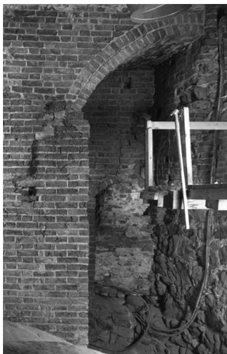
Fig. 4: Sakristivindens sydöstra hörn. Långhusmuren t.h., tegelsakristians murverk t.v. I fonden av nischen däremellan ses den övre sakristians mur, med den igenmurade dörröppningen. Foto P. O. Welin 1977. Museiverket.
