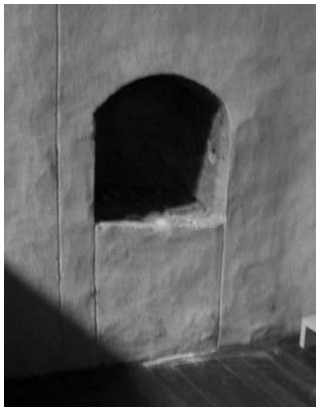
Fig. 5: Den igenmurade dörren till sakristivinden i norra korläktarens västra vägg. Foto K. Drake 2009.
