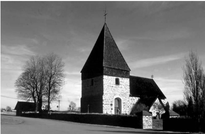
Eckerön kirkko lounaasta. Etualalla näkyvä torni muurattiin 1460-luvun lopulla, kun taas sen takana oikealla oleva runkokuoli noin vuoden 1400 tienoilla. Asehuone eli eteinen muurattiin viimeiseksi vuoden 1500 tienoilla. Valok. kirjoittaja 2005.
