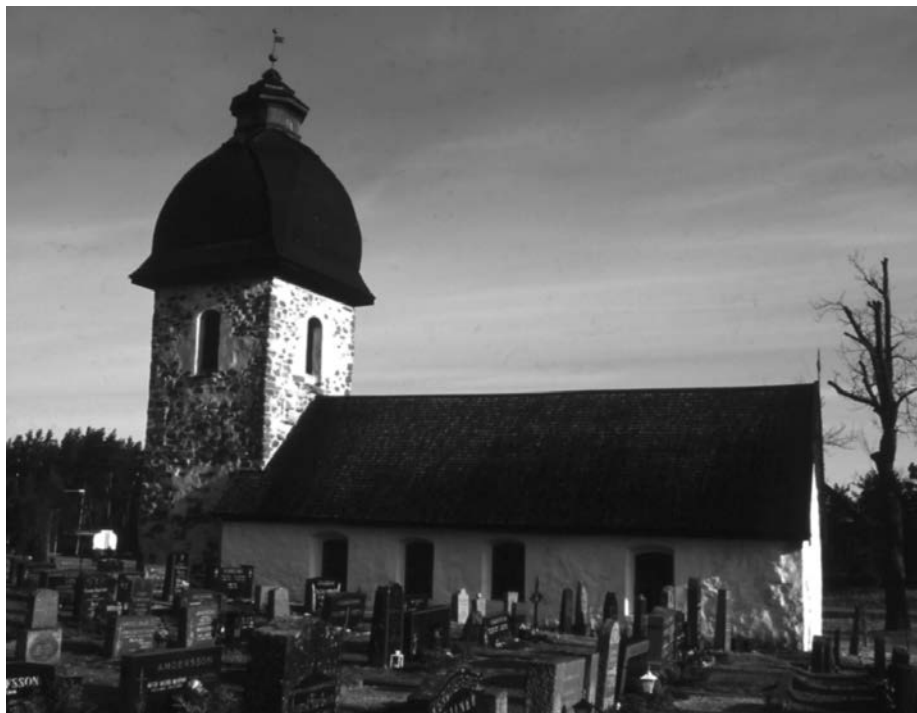
Vårdön kirkko etelästä. Rakennuksen vanhin, aivan keskiajan lopussa tai mahdollisesti jopa uuden ajan alussa muurattu osa näkyy kuvassa oikealla, ja se ulottui aikanaan oikealta (idästä) laskien kolmannen ikkunan kohdalle. Runkohuoneen länsiosa on vuodelta 1784 ja torni vuodelta 1805. Hiekkanen 2007, hakusana Vårdö. Valok. kirjoittaja 2005.
