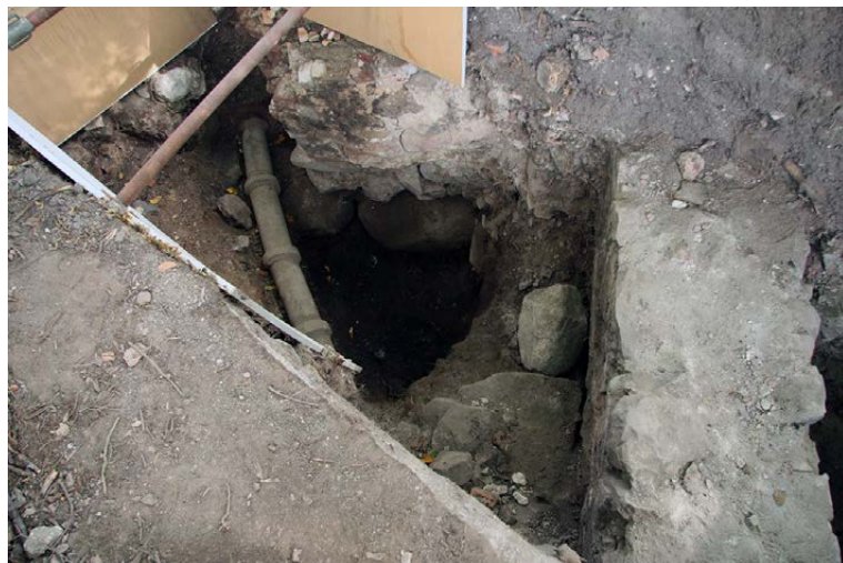
Kuva 2. Kaivauskuoppa K0. Kaivannosta paljastui osittain L:n mallisen kivitalon raunio, jonka 1920-luvulla kaivettu viemäriputki halkaisee. Kaikki kuvat: Ilari Aalto/Aboa Vetus & Ars Nova.
