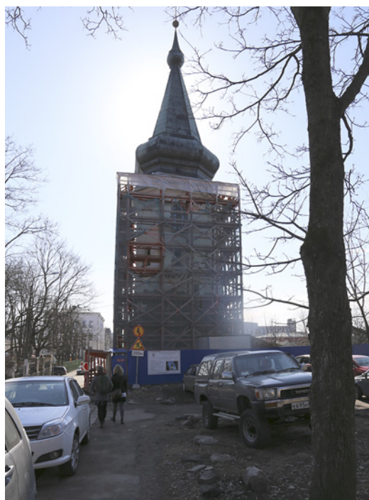
Kuva 1. Restauroitavana oleva vanha kellotorni. Kuva: Elina Terävä.
