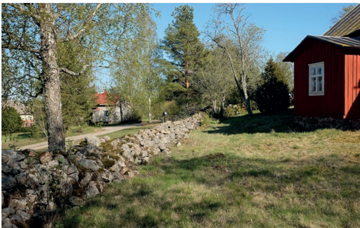
Kuva 10. Laitilan Untamalan muokkaamattomista luonnonkivistä kasattua kirkkomaan aita. Kuva: J. Ruohonen.
