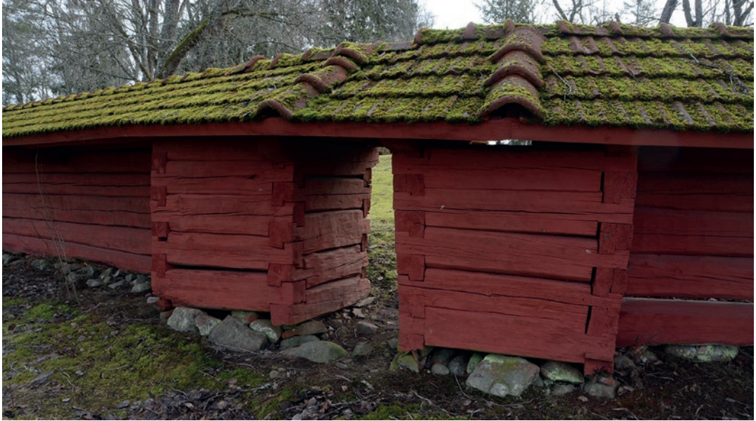
Kuva 18. Pöytyän vanhan kirkkomaan salvosaidassa on kuusi päällekkäin asetettua hirttä ja tiilikate. Aita on rakennettu matalan kiviperustuksen päälle. Kuvassa luoteisosan kapea ja matala sisäänkäynti. Kuva: J. Ruohonen.
