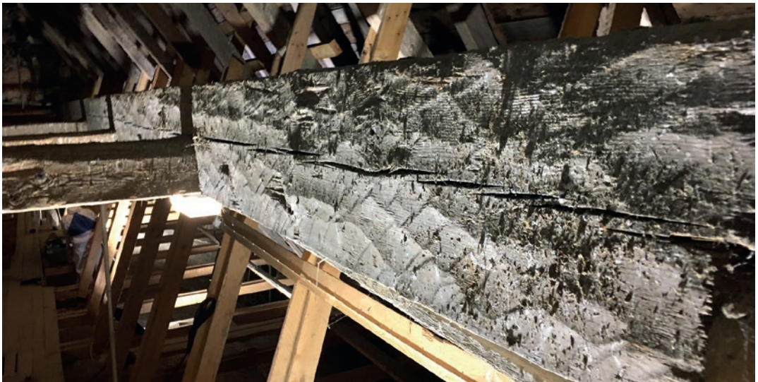
Kuva 7. Pohjan kirkon ullakolla olevan kierrätyspalan, aiemman puukirkon alapaarteen, veistojälki poikkeaa huomattavasti 1470-luvun kattorakenteiden veistojäljestä. Kuva: P. Savolainen.
