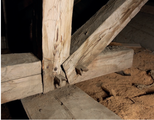
Kuva 6. Konttipuun ja saksen tapitettu lapaliitos alapaarteeseen on tehty romaanisen kattotuolirakenteen mukaisesti, eikä vesikattorakenne tukeudu konttipuun alaosaan jalasparrun tai muurin kylkeen. Rakenne mahdollistaa myös laipiolaudoituksen naulaamisen suoraan alapaarteeseen. Liitoksessa tapeissa on erityisen kauniisti viimeistellyt kannat. Kuva: Pauliina Saari.
