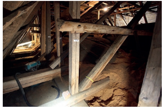
▲▲ Kuva 8. Näkymä etelän puoleiselta konttikäytävältä länteen päin. Katkaistut alapaarteet lepäävät ulomman ja sisemmän jalasparrun päällä. Jalasparrujen välissä ei ole täyttöä. Joka kolmannen kattotuolin alapaarre on tehty järeämmästä puutavarasta kuin muut alapaarteet. Kuva: Mia Puranen.
