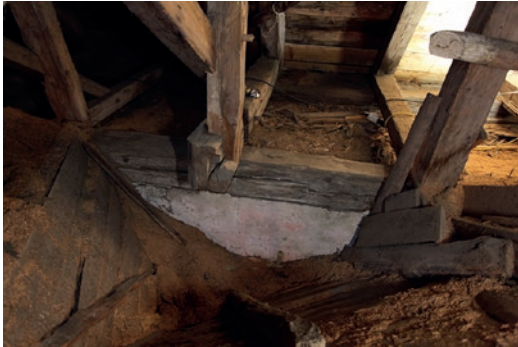
▲▲ Kuva 8. Näkymä etelän puoleiselta konttikäytävältä länteen päin. Katkaistut alapaarteet lepäävät ulomman ja sisemmän jalasparrun päällä. Jalasparrujen välissä ei ole täyttöä. Joka kolmannen kattotuolin alapaarre on tehty järeämmästä puutavarasta kuin muut alapaarteet. Kuva: Mia Puranen.
