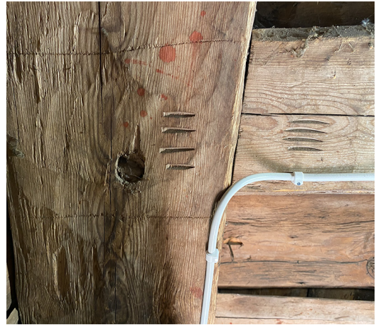
Kuva 6. Lokalahden kellotapulin rakennusosien työmaa-aikaisia numerointeja ja kohdistusmerkintöjä. Kuva: Panu Savolainen.
