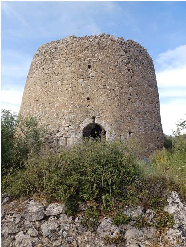
Kuva 1. Graikokhorissa Igoumenitsasta itään vievän moottoritien varrella seisova tornimainen raunio paljastui lähemmässä tarkastelussa 1900-luvulla rakennetuksi tuulimyllyksi. Siihen viittaavat myös esimerkiksi pohjakerroksessa oleva iso ovi-aukko ja ampuma-aukkojen puute. Kuva: Nikolai Paukkonen.
