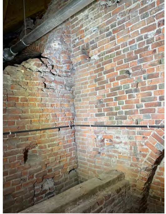
Kuva 4. Ullakoilla näkyvät tiiliseinät muodostavat hyvin monivaiheisen eri-ikäisten tiilimuurauksen kerrostuman. Kuvassa alkuperäisen runkohuoneen koillisnurkka ja 1400-luvulla toteutetun laajennetun kuorin transeptin länsiseinä. Kumpikin vaiheista on sitten peittynyt myöhempien lisäysten ja vesikattojen alle. Kuva: Tanja Ratilainen.
