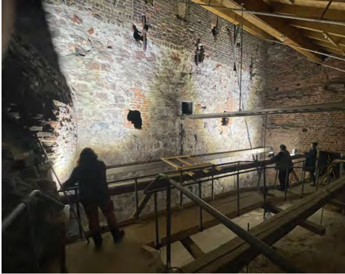
Kuva 3. Tornin alkuperäistä pohjoisjulkisivua Tarkka'ampujainkappelin ullakolla. Kuva: Sofia Paasikivi.
