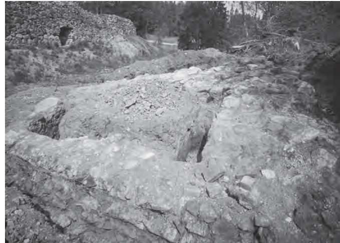
Kuva 12. Rakennuksenperustuksen kaakkoiskulma sekä itä- ja eteläseinät kuvattuna kaakosta. Taustalla itäisen esilinnan pohjoispääty ja ns. vesiportti. Kuva: Olof Welin 1968. Museovirasto, Historian kuvakokoelma, HK19711231D:8.
