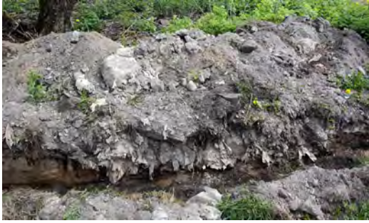
Kuva 4. Stallholmenilta vuoden 2017 kaapelikavannosta esiin tulleita betonisäkkejä. Kuva: Tarja Knuutinen.
